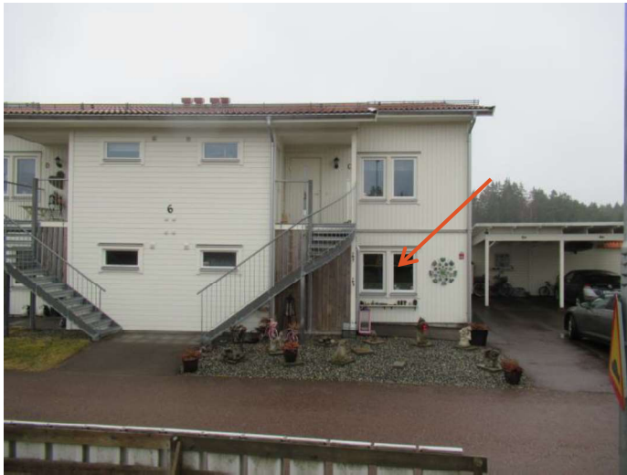
Foto, huvudbyggnad. Pilen visar lägenhetens läge.
