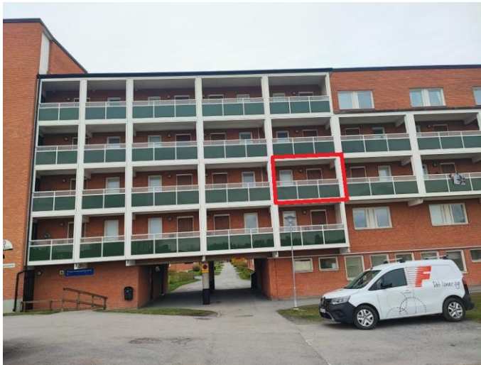
Foto, fasad mot Semsåvågen med loftgångar, markering visar läget för lägenheten.
