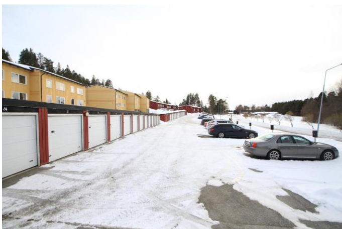
Foto, parkeringsplatser, garage med vita portar.)
