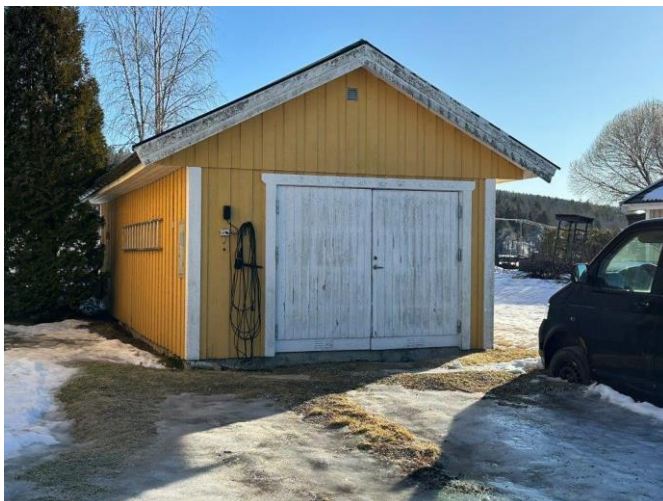
Foto, fasad garage med gulmålad träpanel samt vit port och vita detaljer..
