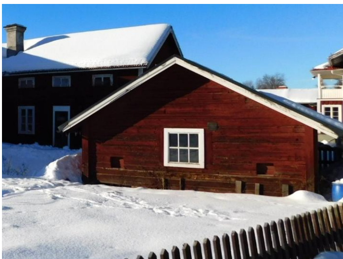
Foto, övrig byggnad 4, stuga/förråd, taget från vägen, rödmålad träfasad.
