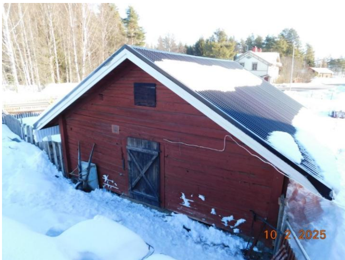
Foto, övrig byggnad 4, stuga/förråd, taget från logen, rödmålad träfasad.
