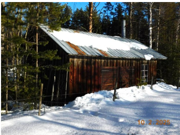
Foto, övrig byggnad 7, fd smedja, brunmålad träfasad.
