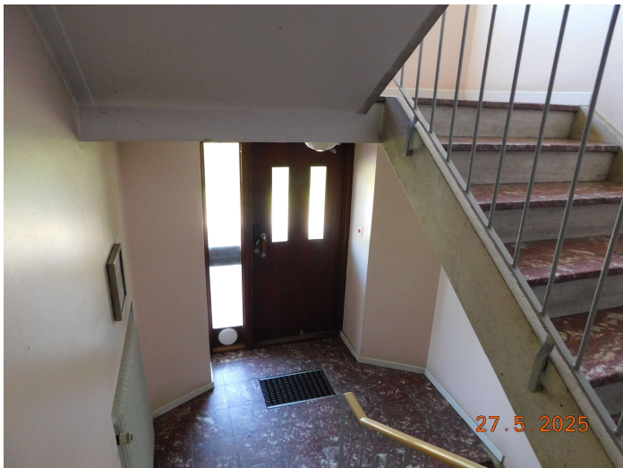
Foto, trapphus, stensatt golv och trappor.
