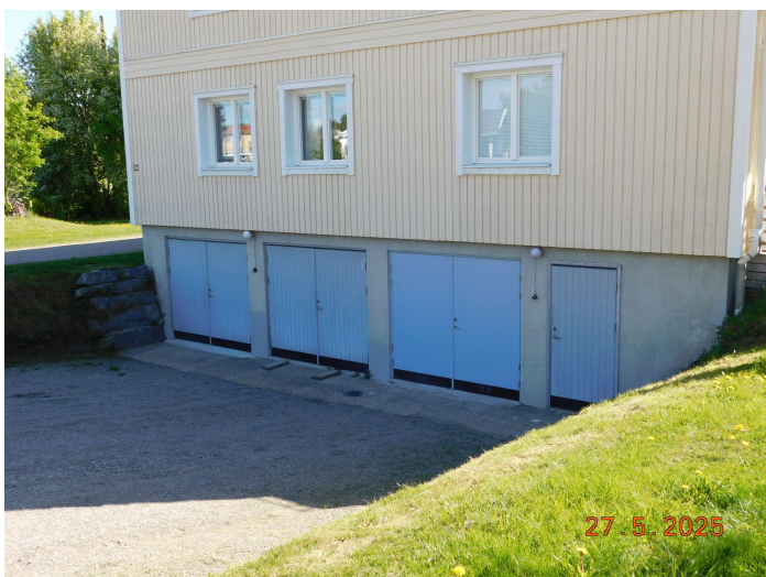
Foto, huvudbyggnad, garageplatser med slagportar.
