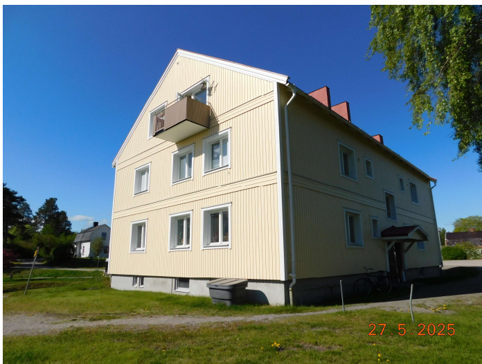
Foto, huvudbyggnad, ljusmålad träfasad, inredd vind med balkong.
