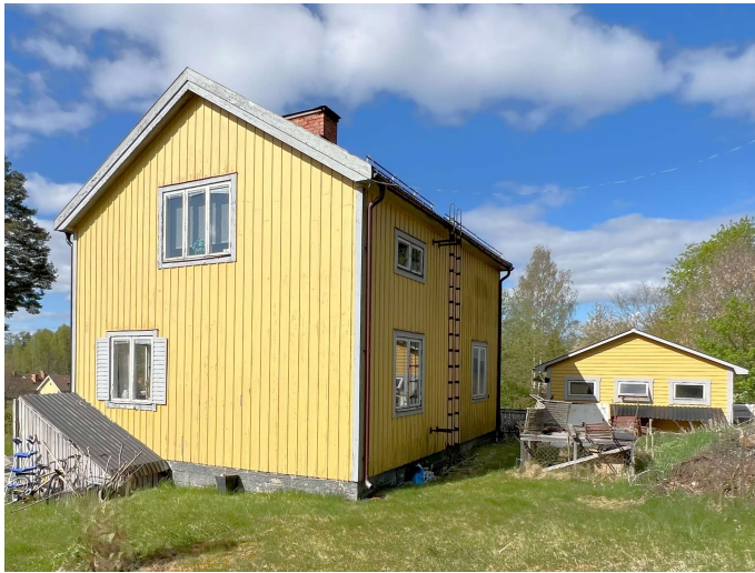
Foto. Huvudbyggnad. Källarnedgång (vä). Garage (hö).
