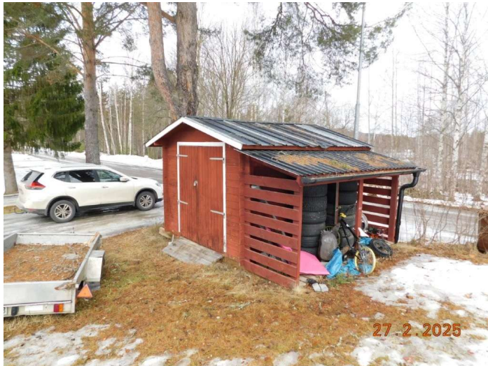
Foto, byggnad 2, förråd vi fastighetens infart, rödmålad träfasad.
