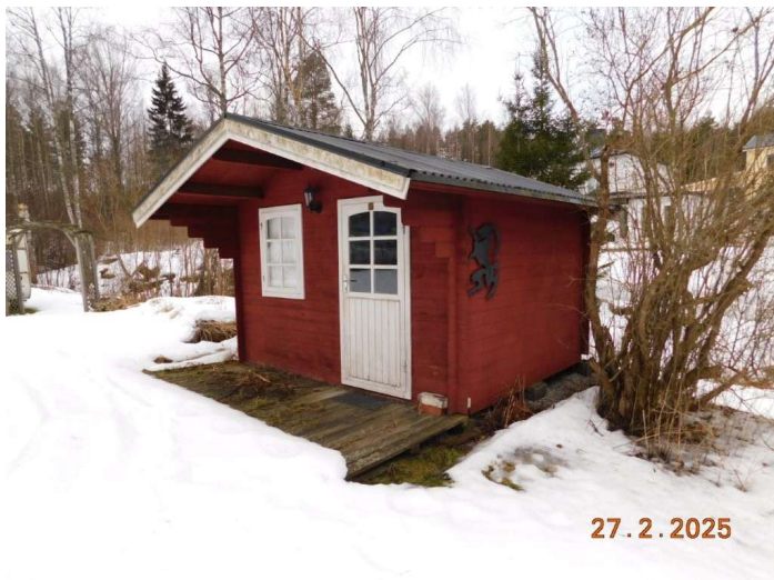
Foto, byggnad 3, friggebod/stuga, rödmålad träfasad med vita detaljer.
