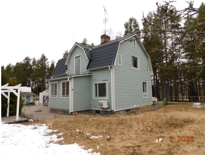
Foto, huvudbyggnad, gråmålad eternitfasad med vita detaljer, gräsmatta.
