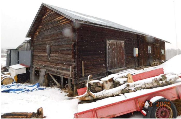
Foto, byggnad 2, baksida, förråd och carport, snötäckt mark.
