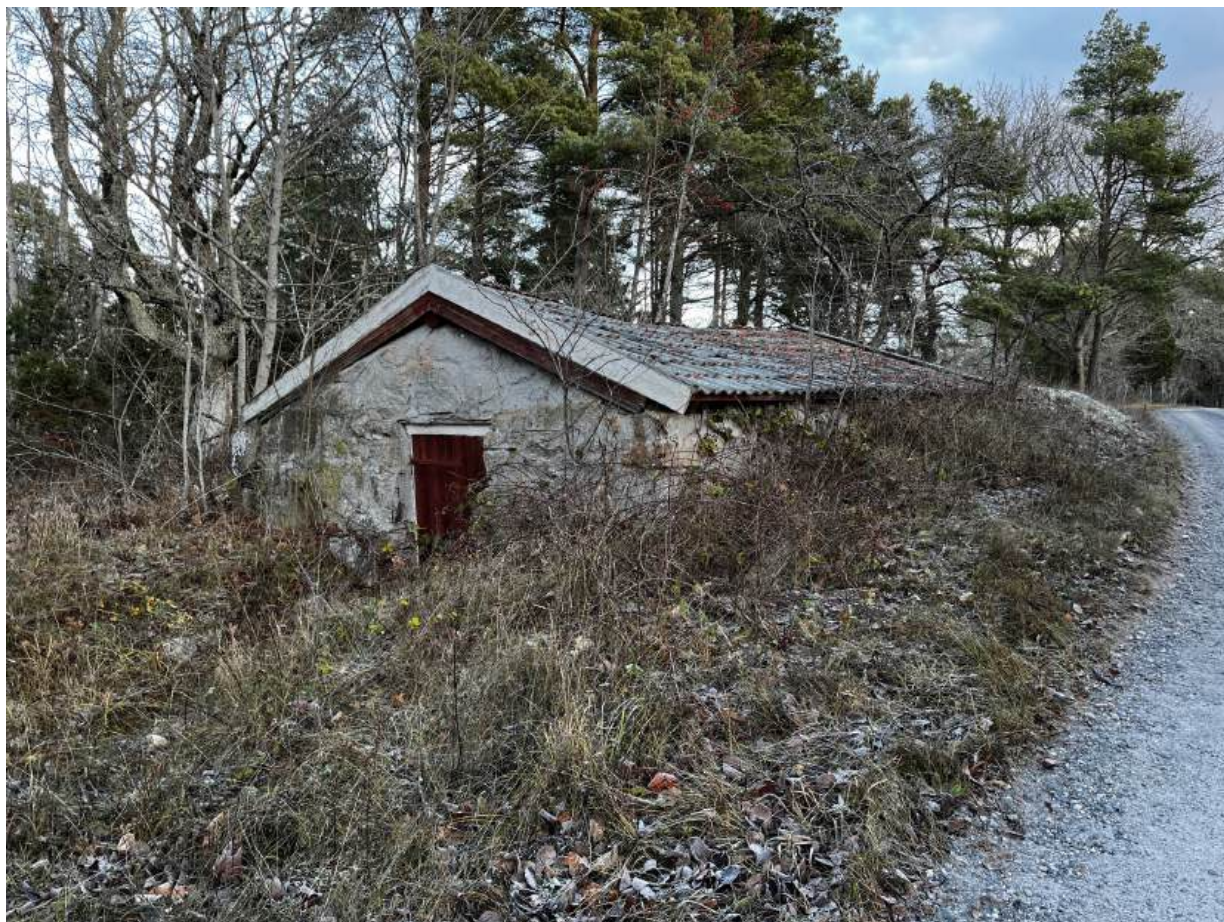
Bild 5: Byggnad 4, västra och södra sidan
