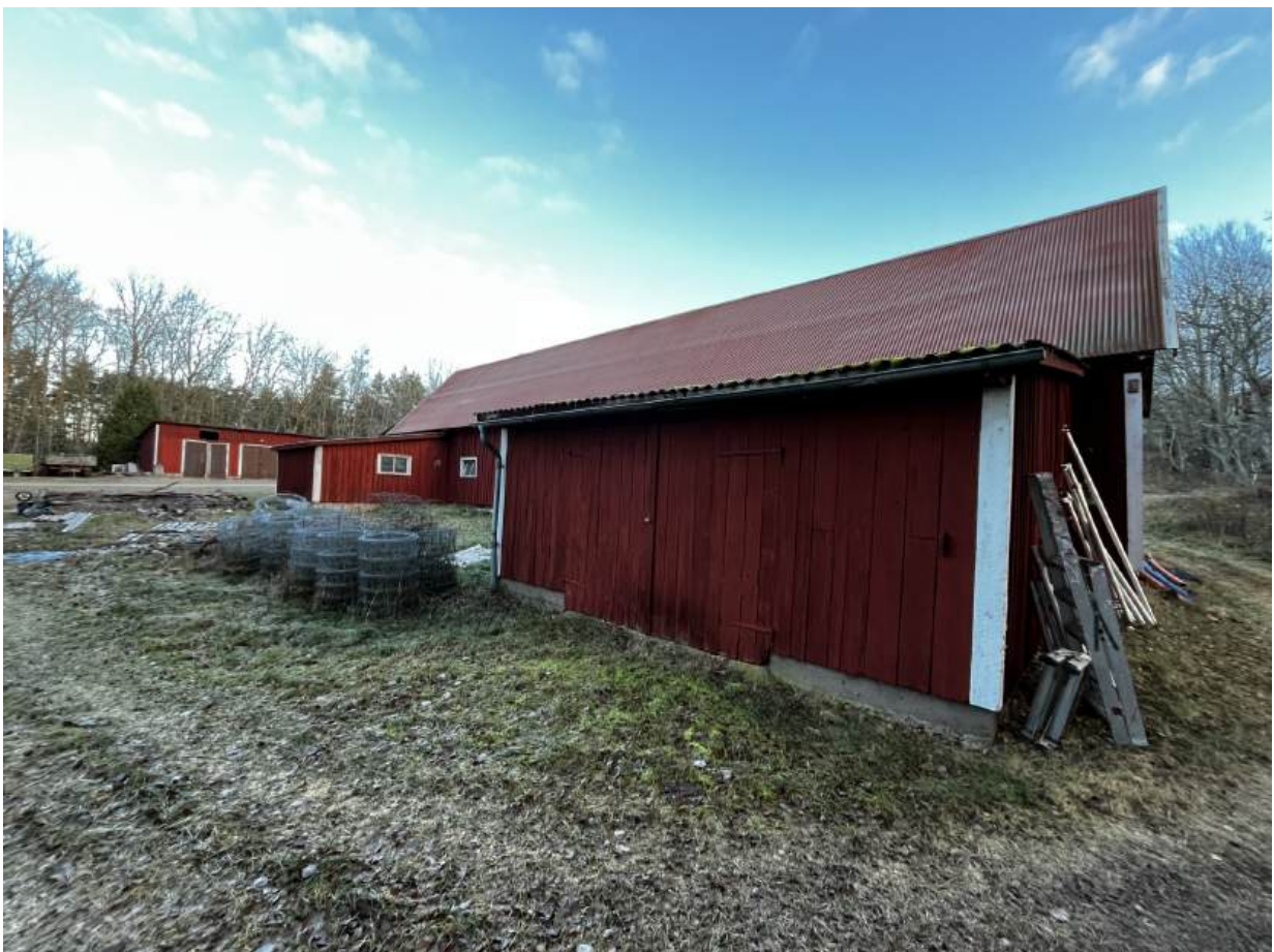
Bild 4: Byggnad 3, västra sidan
