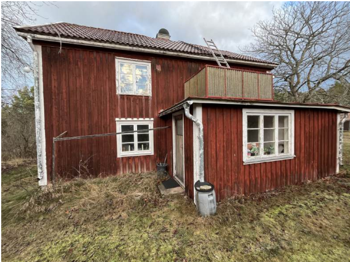
Bild 1: Byggnad 1, norra sidan
