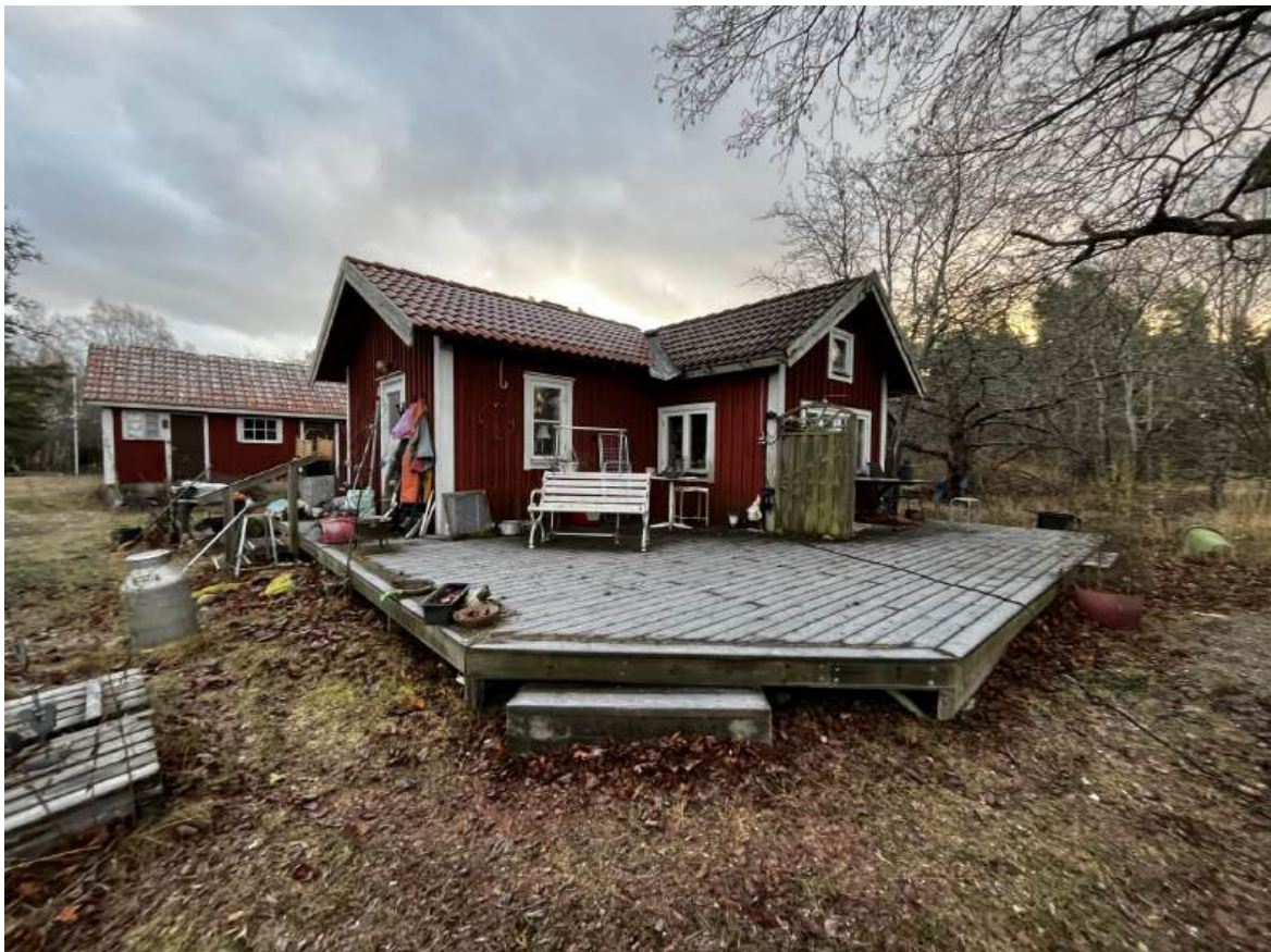
Bild 2: Byggnad 2, norra och västra sidan
