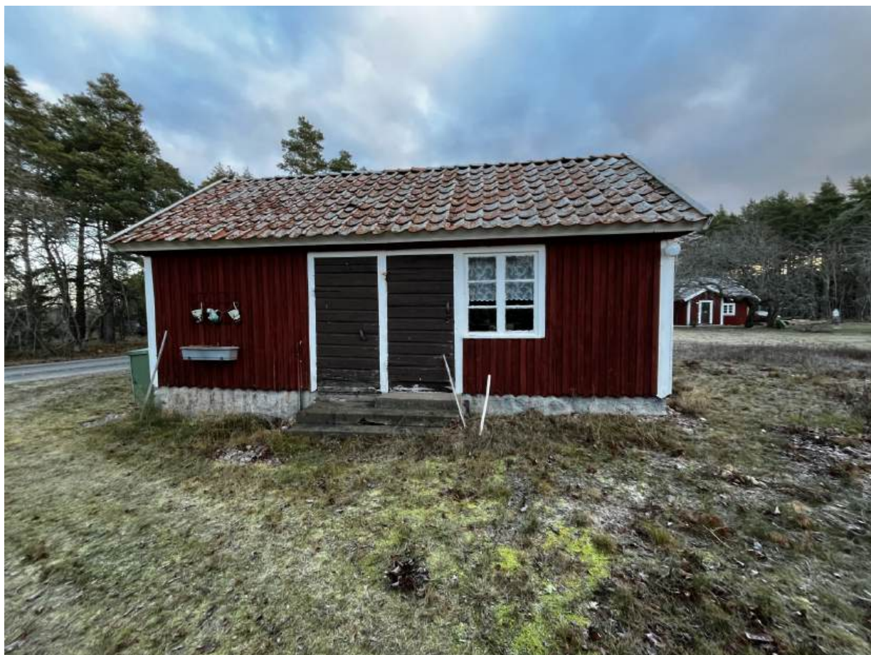
Bild 6: Byggnad 5, västra sidan
