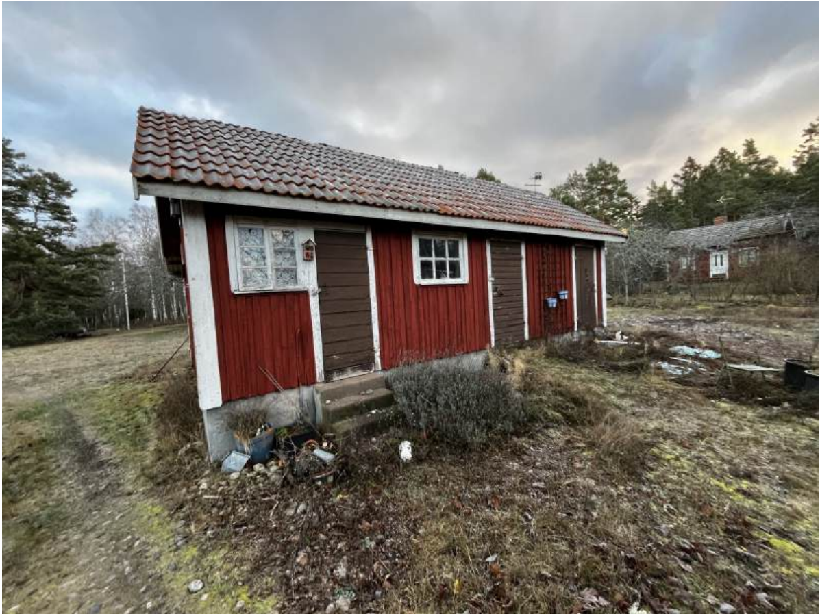
Bild 7: Byggnad 6, västra sidan
