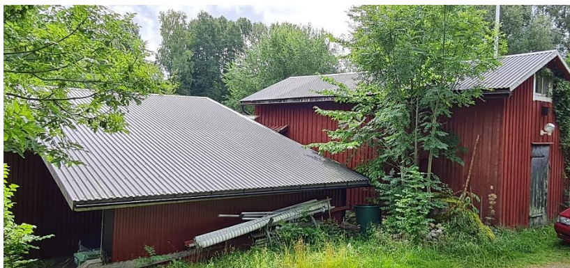
Uthus till höger, carport till vänster
