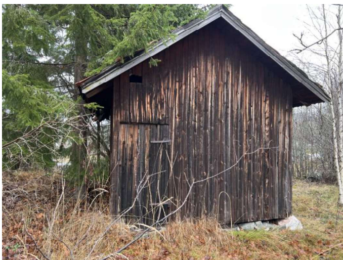
Foto, byggnad. Äldre byggnad med träfasad.
