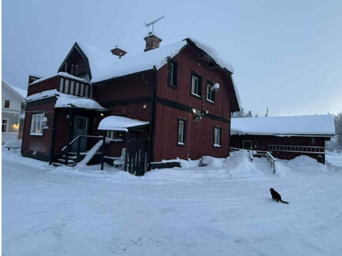
Foto huvudbyggnaden utvändigt. Rödmålad träpanel med mörka detaljer. Snötäckta markytor på innergården.
