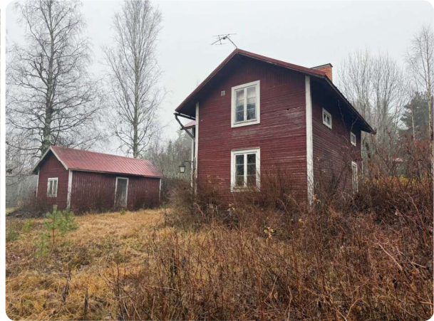
Huvudbyggnadens baksida och förråd ses i bild.
