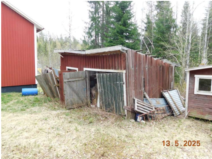
Foto, förfallen förrådsbyggnad.
