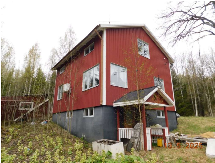
Foto, huvudbyggnad, fasad öster, rödmålad träfasad, källaringång.
