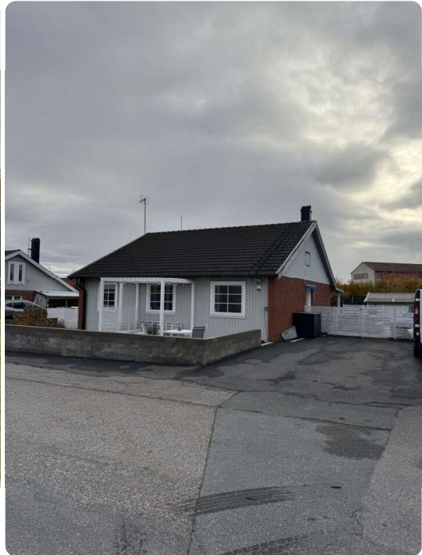
Småhus i ett plan med fasad av tegel och träpanel, yttertak av betongpannor samt asfalterad uppfart
