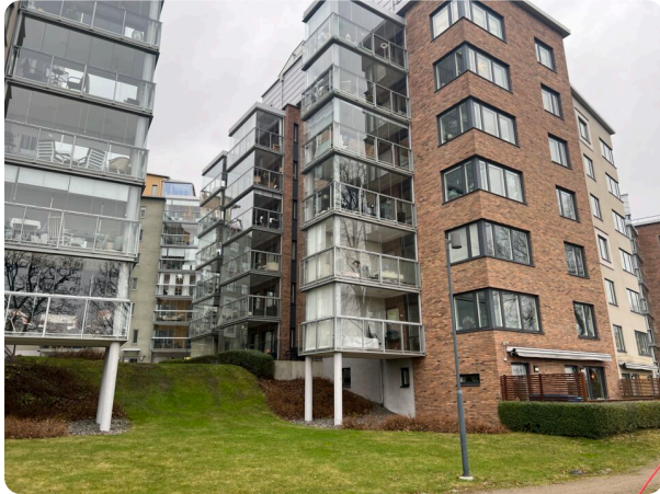
Flerbostadshus med fasader av puts och tegel
