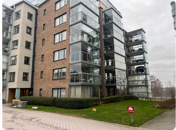
Flerbostadshus med fasader av puts och tegel
