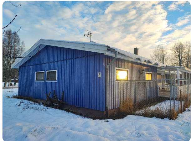
Gaveln på vidbyggda garaget/förråd
