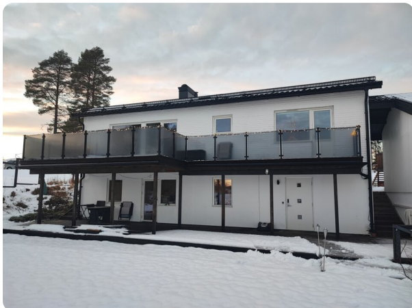
Framsida huvudbyggnad med uteplats samt balkong
