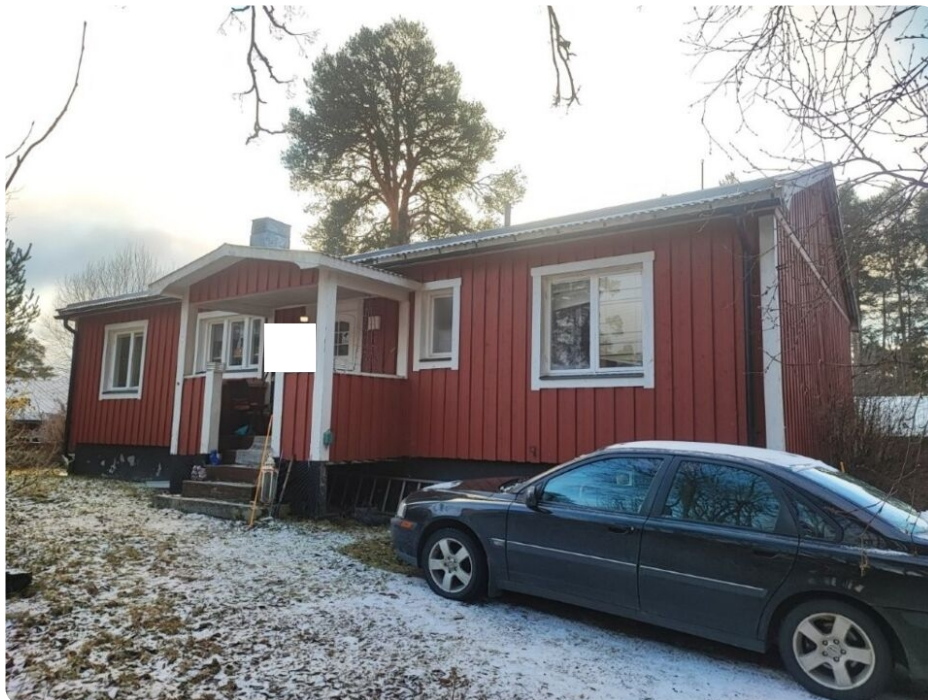
Foto huvudbyggnadens entré med rödmålad fasad med vita detaljer
