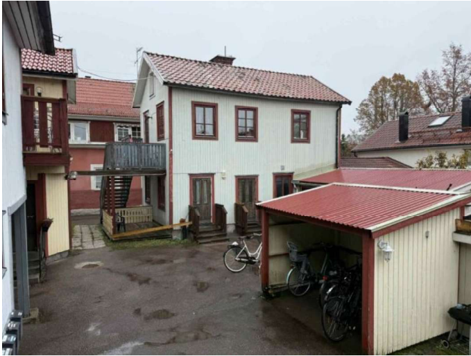
Foto, Trädgårdsgatan 3B, cykelförråd och asfalterad innergård
