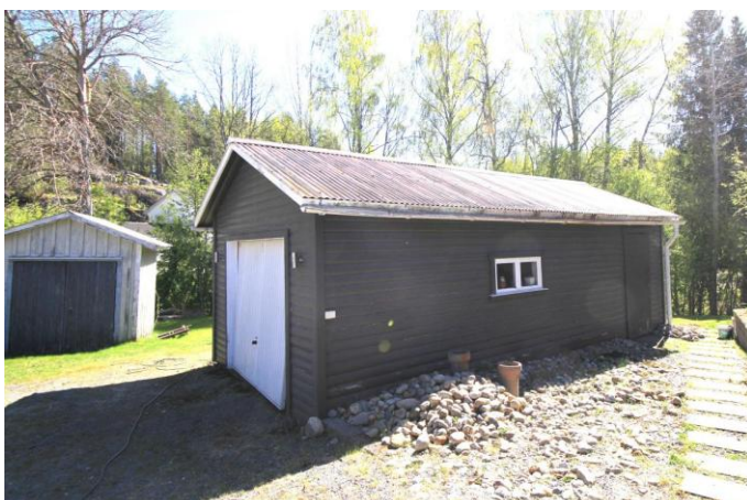
Foto, garagebyggnad, mörkgråträpanel, vita detaljer.
