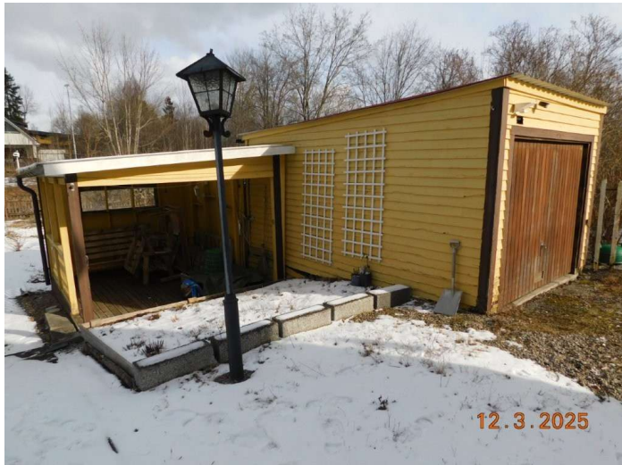
Foto, byggnad 2, garage & förråd. Gulmålad träfasad med pulpettak.
