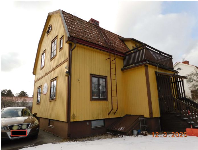
Foto, huvudbyggnad, entréside, gulmålad träfasad med bruna detaljer, snötäckt mark.
