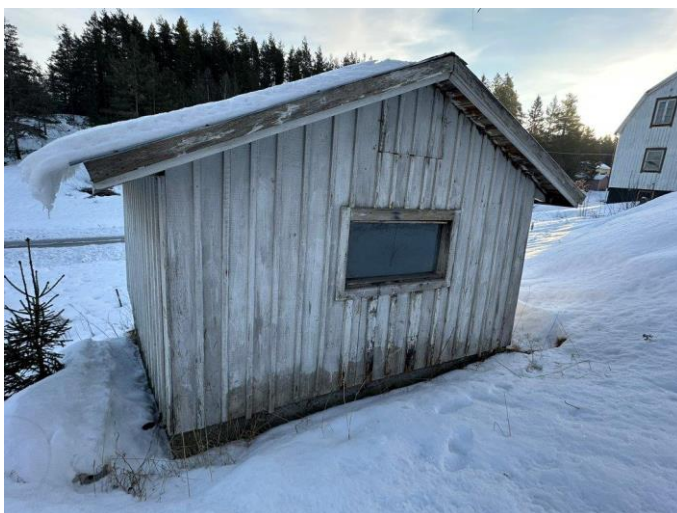
Foto, förrådsbyggnad med vitmålad träpanel
