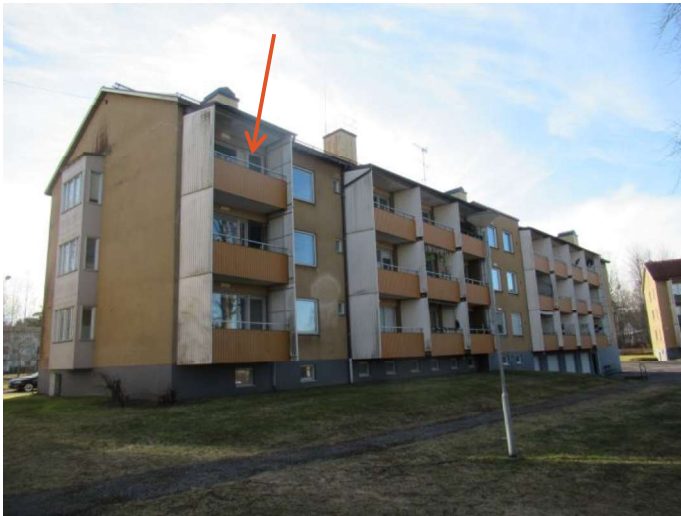
Foto, huvudbyggnad från baksida. Pilen visar balkongens placering.
