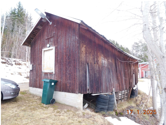
Foto, byggnad 3, förråd, äldre byggnad vid infart till fastighet, träfasad och plåttak.
