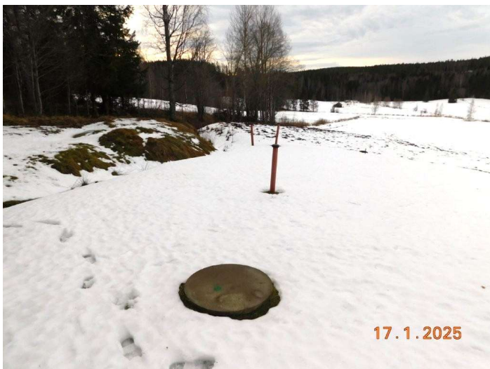
Foto, enskilt avlopp, avloppsbrunn m.m.
