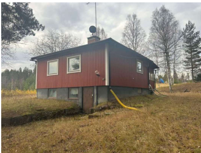
Foto, vy över huvudbyggnadens baksida med separat källarentré.
