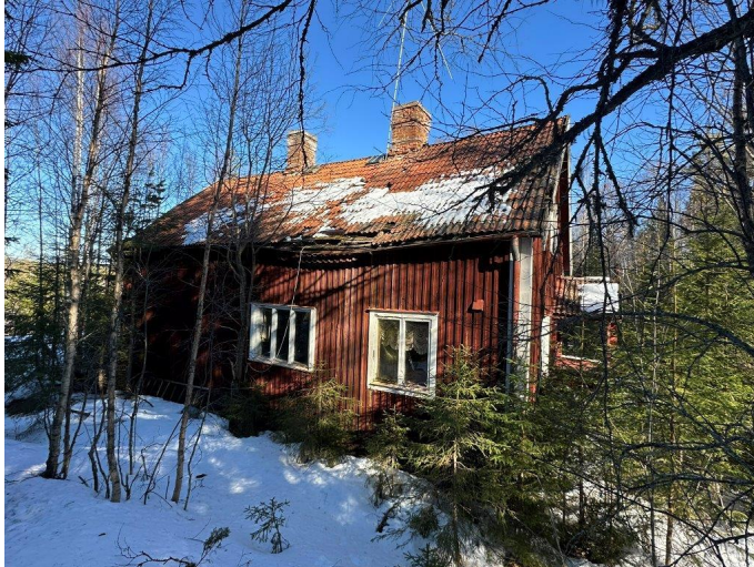
Foto, huvudbyggnad. Fasad långsida med rödmålad träpanel och vita detaljer. Tegeltak i dåligt skick.
