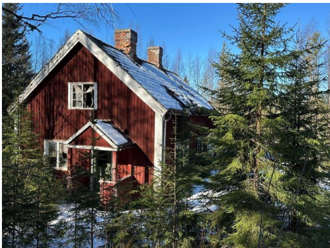
Foto, huvudbyggnad. Fasad gavel och långsida med rödmålad träpanel och vita detaljer. Tegeltak i dåligt skick. Brokvist.
