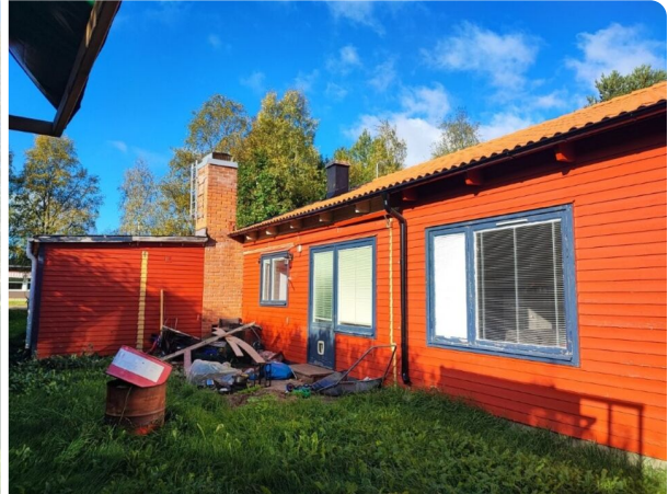
Foto på södra sidan av fastigheten
