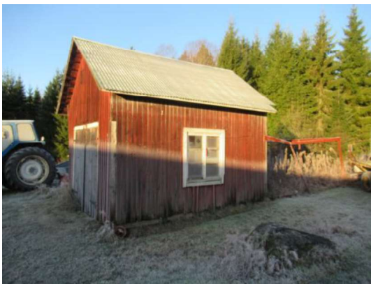
Foto, övrig byggnad, garage 2.
