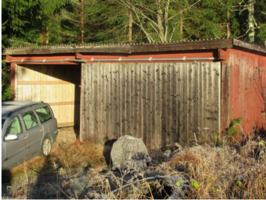
Foto, övrig byggnad, garage 1.
