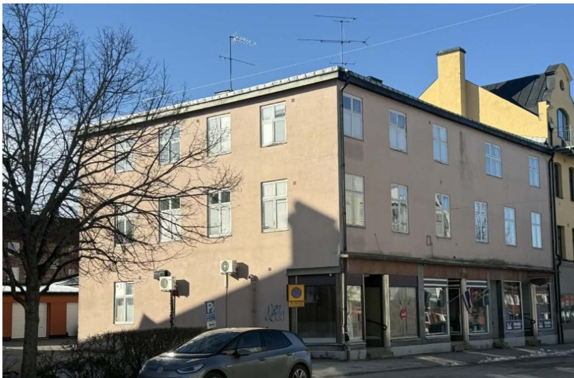
Foto taget utvändigt på värderingsobjektets huvudbyggnad. Putsad fasad med vita detaljer och skyltfönster.
