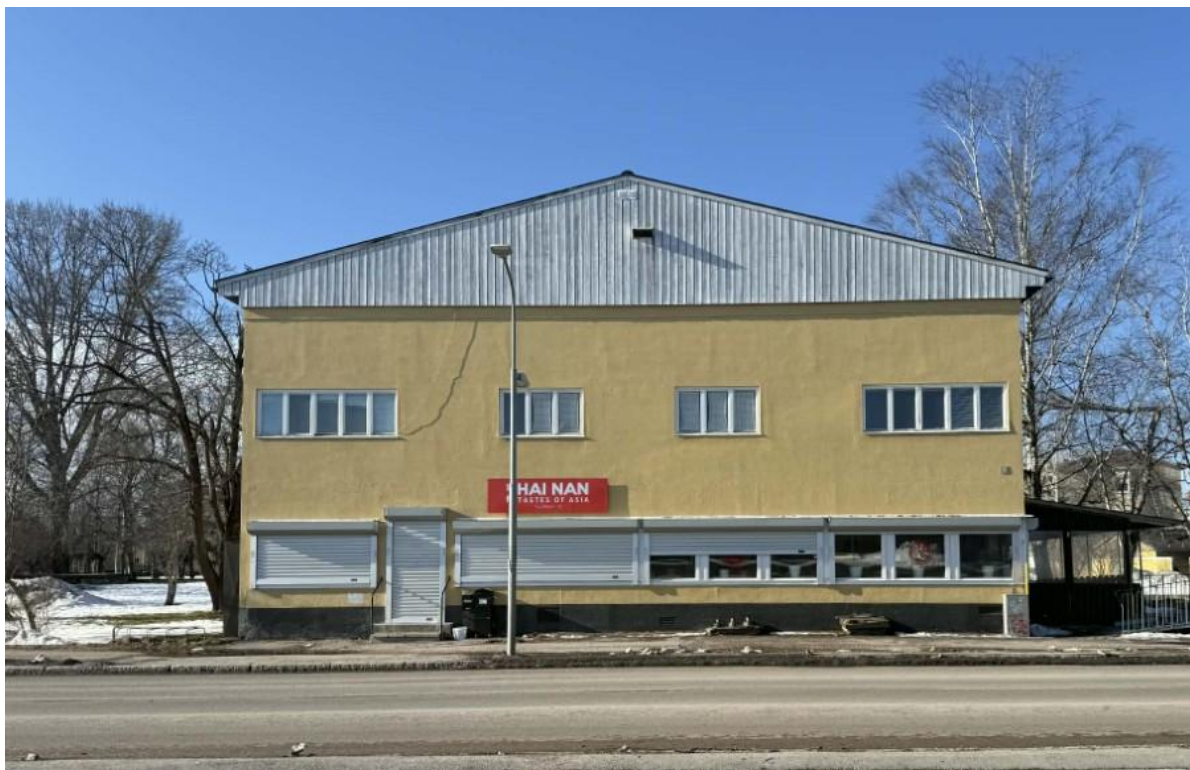
Foto taget utvändigt på värderingsobjektets huvudbyggnad. Fasad av gul puts och ljusst målad träpanel med ljusa detaljer.
