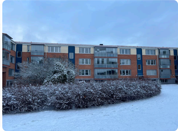
Flerbostadshus med tegelfasad och inglasade balkonger samt buskar och snötäckt mark
