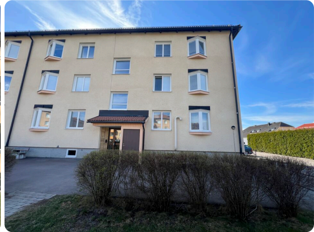
Flerbostadshus med putsad fasad, vy från entrésidan
