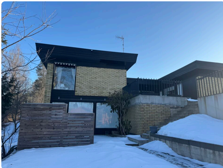
Foto taget på värderingsobjektet. Tegelfasad med bruna trädetaljer och uteplats.
