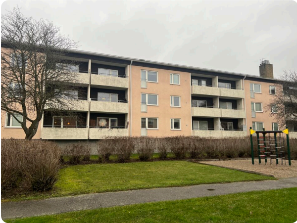
Flerbostadshus i tre plan samt innergård med gräsmatta, buskar och liten lekplats.
