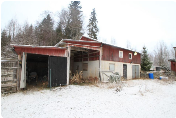
Foto fd ladugård vit puts och rödmålad träpanel med carports.
