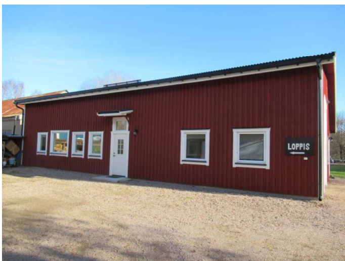
Foto, verkstadsbyggnad med röd träpanel och plåttak.
