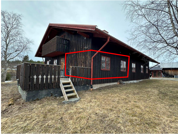
Foto, huvudbyggnad med brun fasad med röda detaljer. Markering visar läget för värderingsobjektet (den mindre delen)
