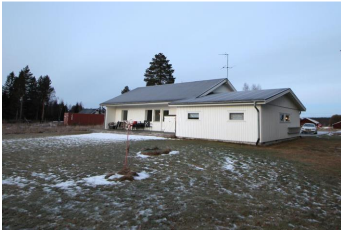
Foto, huvudbyggnad, vit träpanel vita detaljer och svart plåttak.
