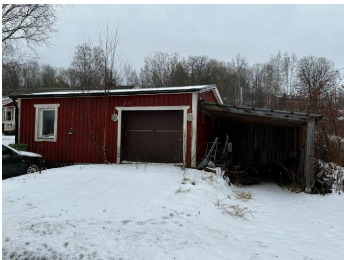
Foto, garage/förråd med rödmålad träpanel samt vita detaljer. Vidbyggt skärmtak.
