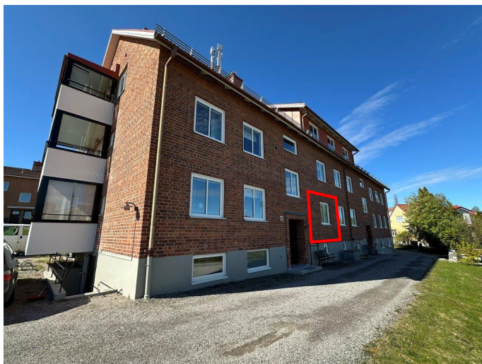
Foto, entréfasad flerbostadshus i tegel med vita detaljer. Markeringen visar lägenhetens läge.
