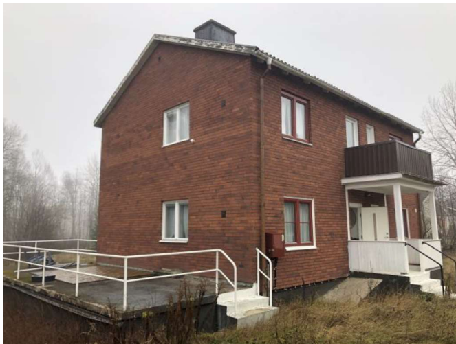
Foto, huvudbyggnad. Byggnad i två våningar med tegelfasad, vita och röda detaljer samt ovårdad gräsmatta
