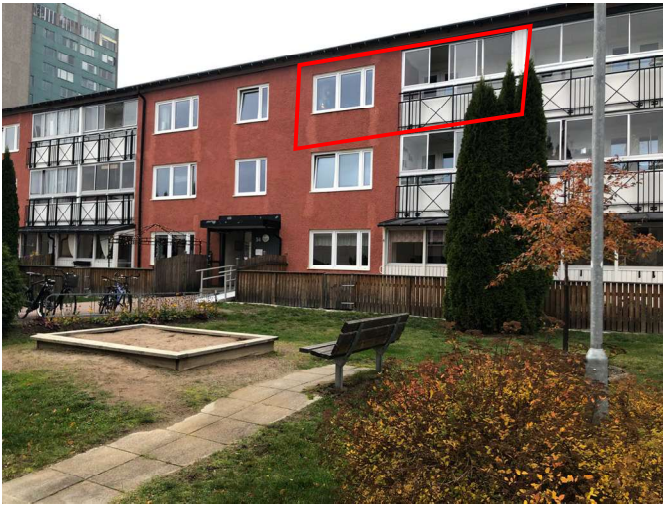
Foto, byggnad. Flerbostadshus i tre våningar, med röd fasad och vita detaljer, värderingsobjektet markerat.
