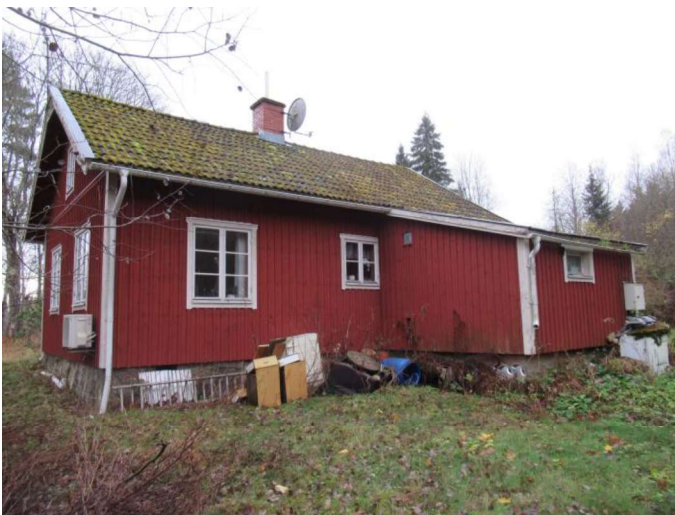
Foto, baksida av byggnaden med utbyggnad innehållande WC och grovingång.
